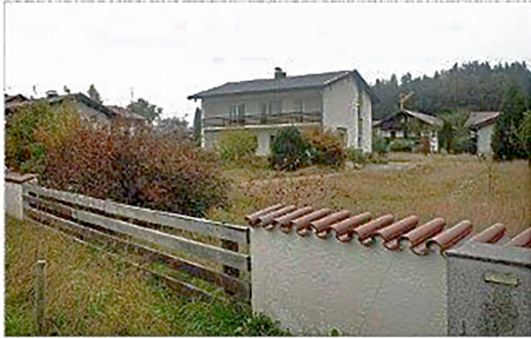
Auf diesem Grundstück – das bestehende Gebäude wird abgerissen – in der Seoner Straße in Truchtlaching soll eine neue Holzbausiedlung entstehen. Insgesamt zehn Reihenhäuser in ökologischer Holzbauweise sind auf dem rund 2700 Quadratmeter großen Grundstück vorgesehen.
